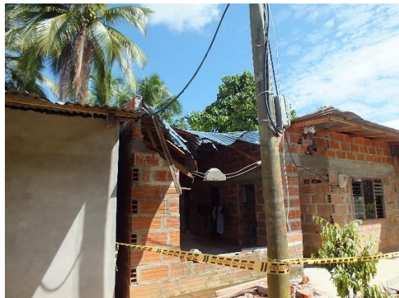
Daños en las viviendas
